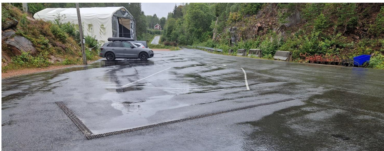
Figur 5: Eksempel på spyleplass med renner (Foto: Mepex)
