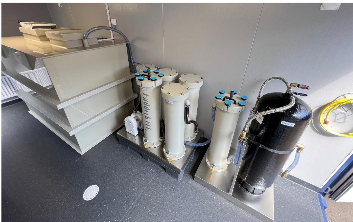
Figur 7: Haddox 600 montert i container (Kilde: www.robustvann.no )
