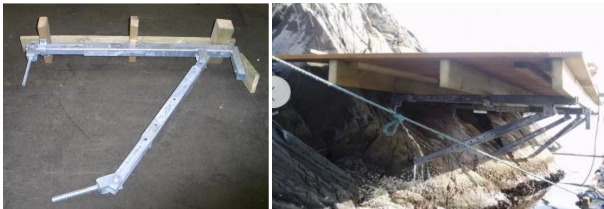
Figur 2: Bilde av konsoll for montering av gangvei og brygger langs fjellveggen.
